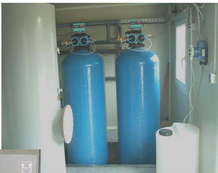
Stație compactă de tratare a apei cu ozon. Echipamente principale
